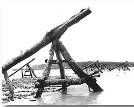
„Hottelbalk“ – низ импровизованих преурека за десантне чамце, искошених греда са проширеним крајевима. У време пиле конструиције налазе се под водом.
